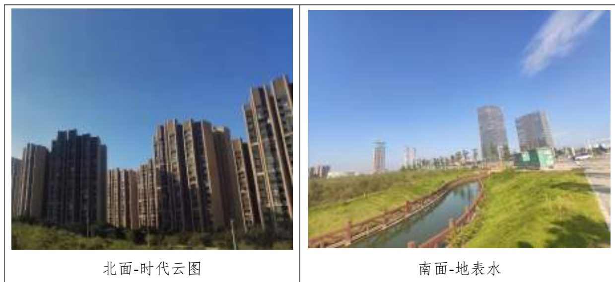
图 4.5-1 地块周边现状照片
