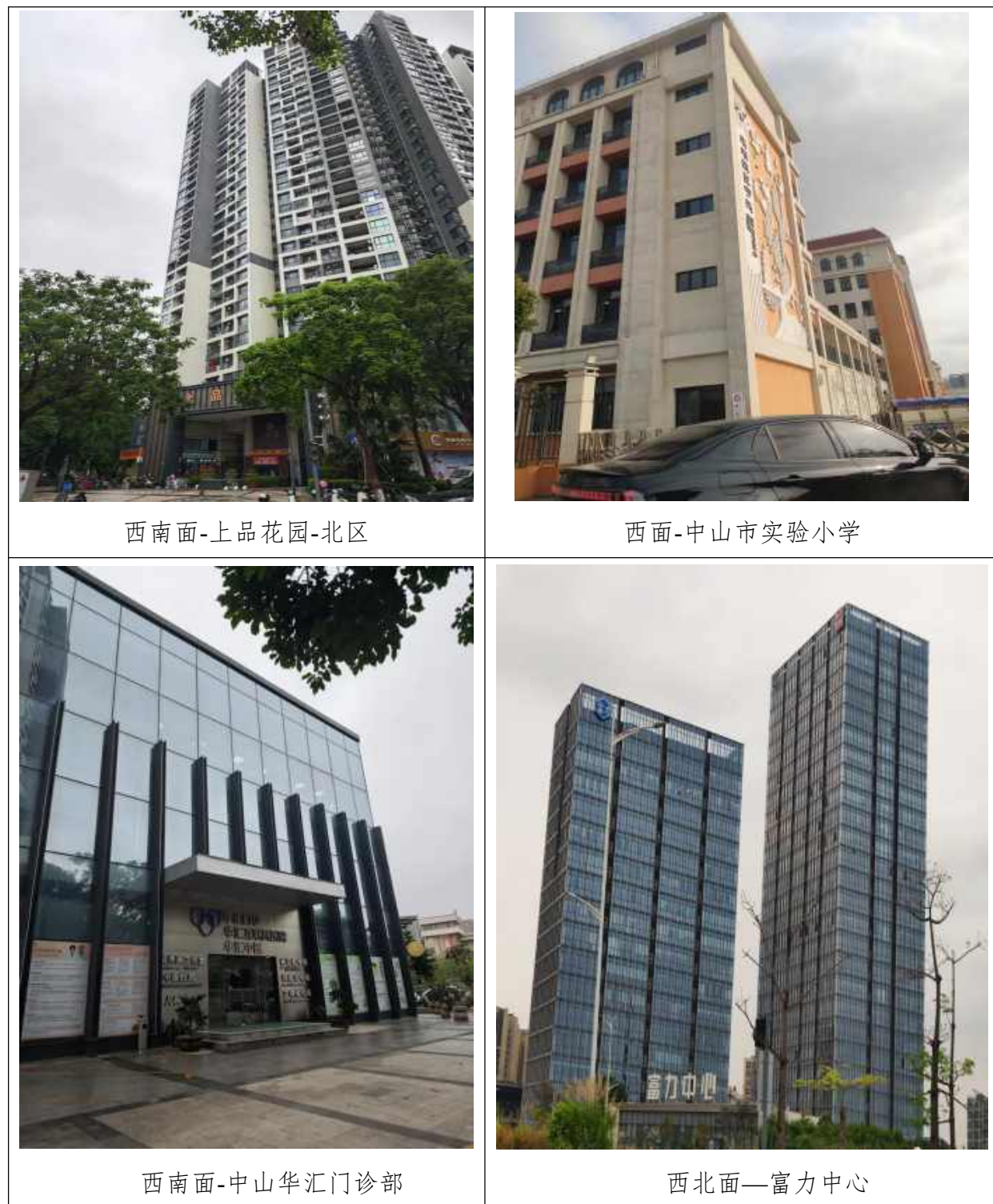
图 4.5-2 地块周边现状照片
