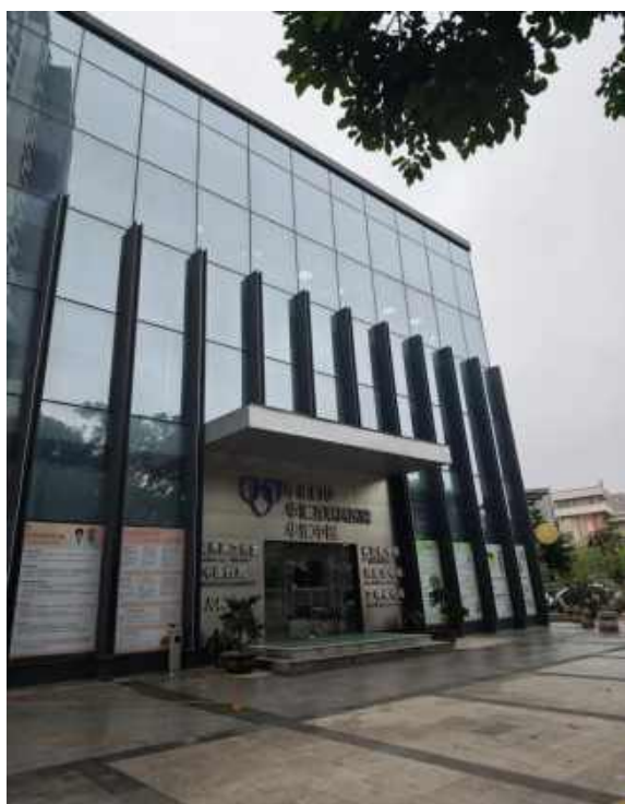
西南面-中山华汇门诊部
