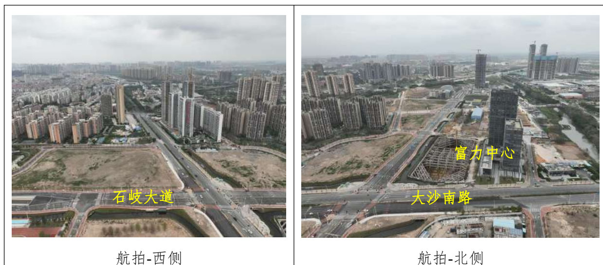
图 4-17 地块周边现状照片
