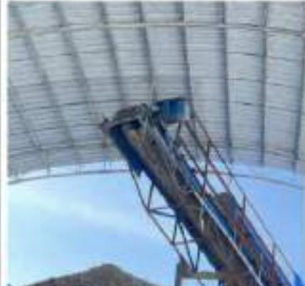
砂石加工系统端部喷淋系统
