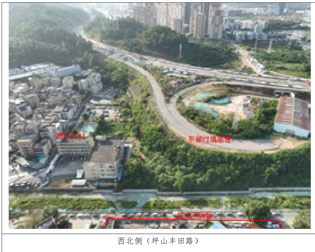
图 2.5-1 相邻地块现场踏勘照片
