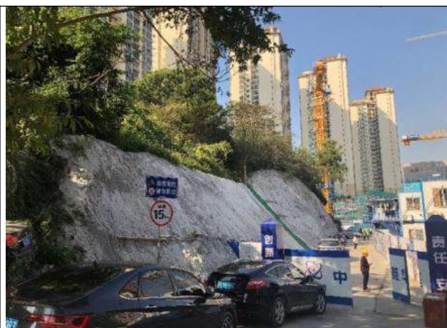
西侧植被覆盖区高差
