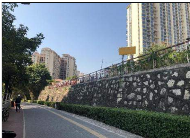
东侧边坡挡墙
