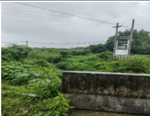
东南面-排洪渠
