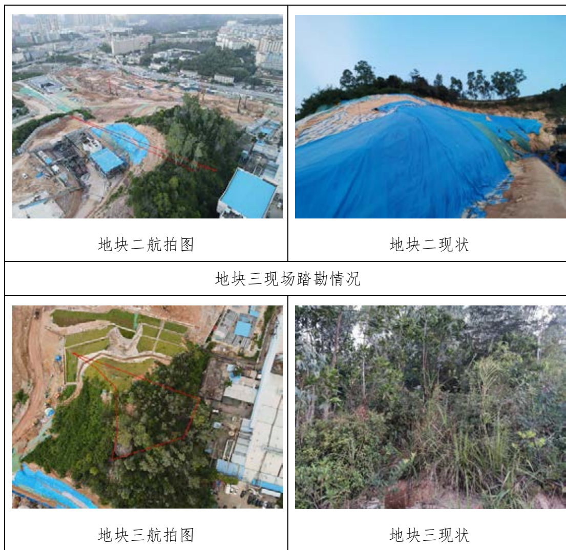
图 3-1 地块内现场踏勘情况
