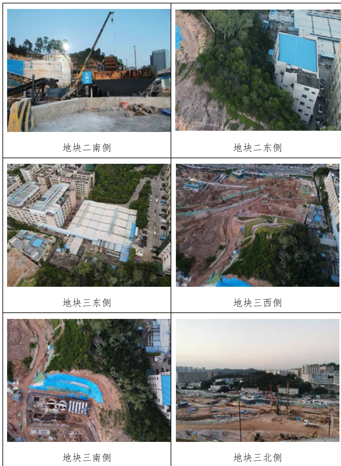
图 3-2 地块相邻区域现场踏勘情况
