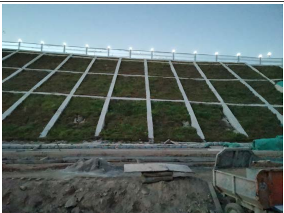
地块一东南侧现状为山体护坡
