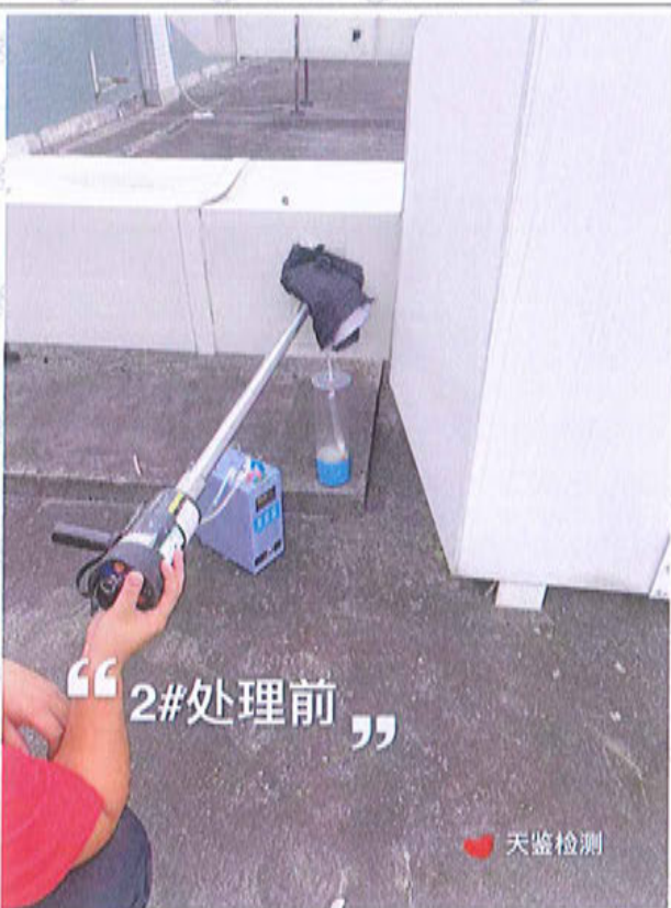
2#排气筒处理前检测口
