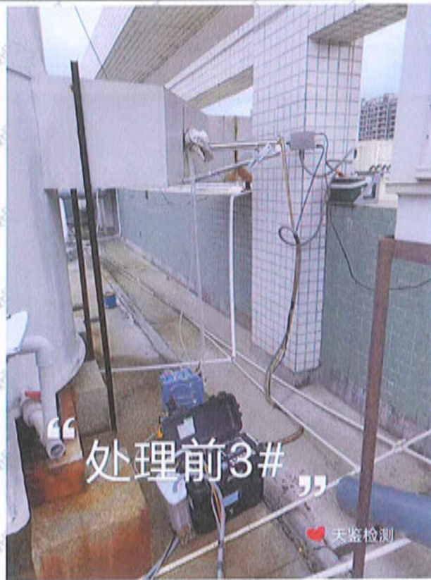
3#排气筒处理前检测口
